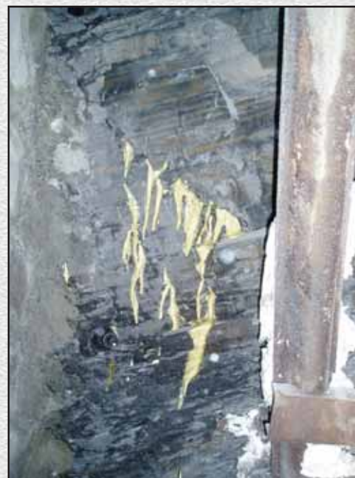
Injektiranje pukotina u blizini barijere u rudniku uglja u Španiji
